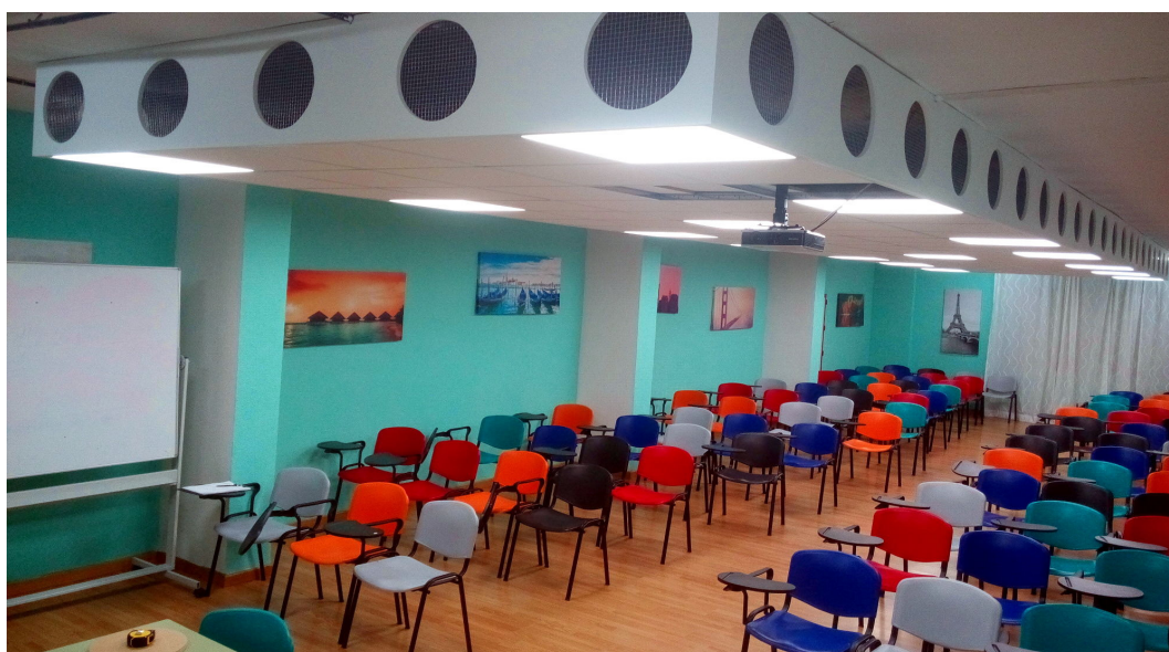
Fig. 1. Red de climatización
